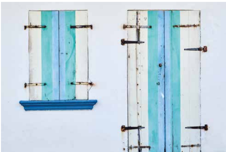
Maison créole/ Architecture ©CMT
